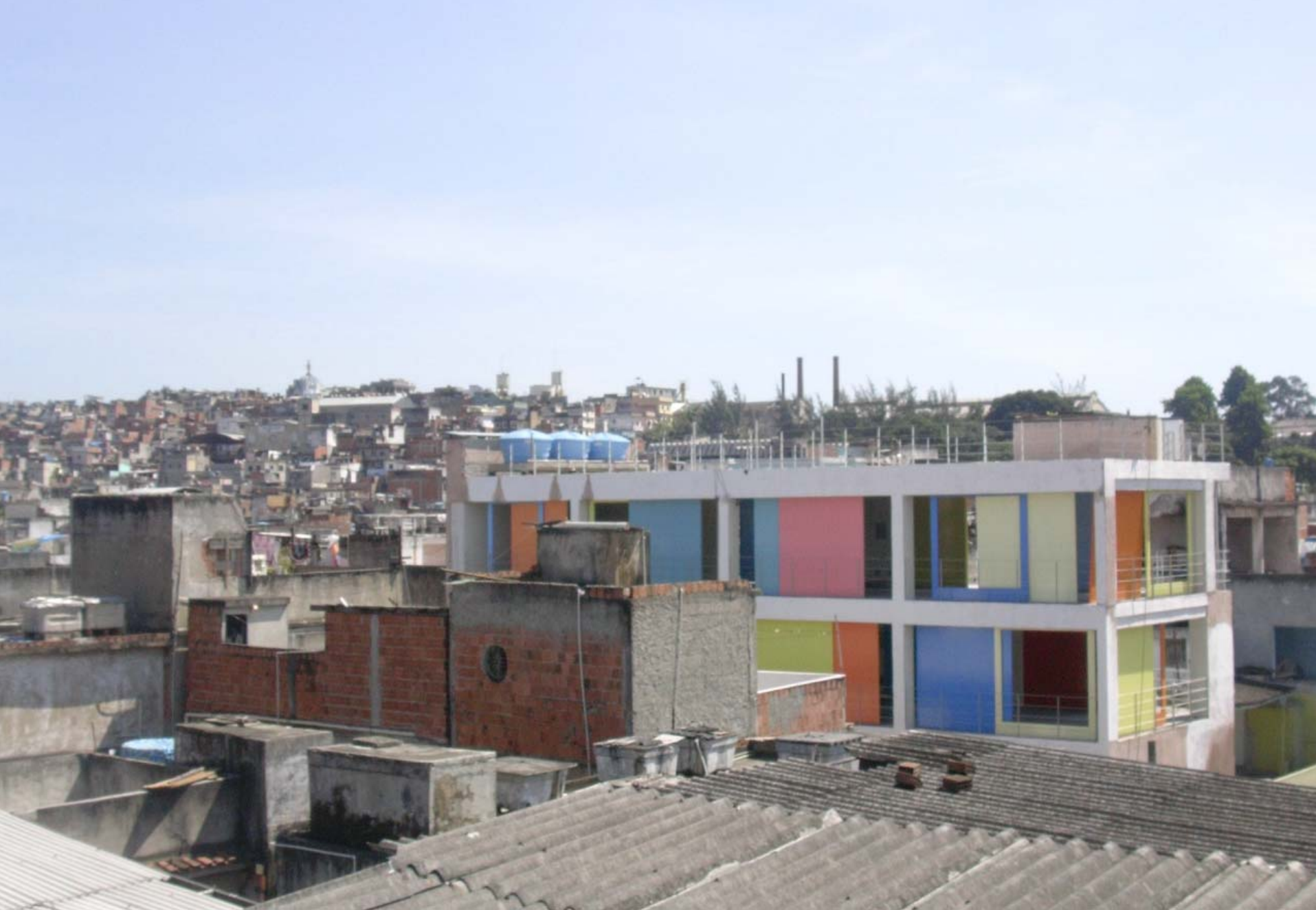
Nucleus – Ausbaurbeiten im April 2004. Im August 2004 ist die Eröffnung des Gebäudes als Medien- und Informationszentrum mit einem Festival der Ars Electronica geplant
