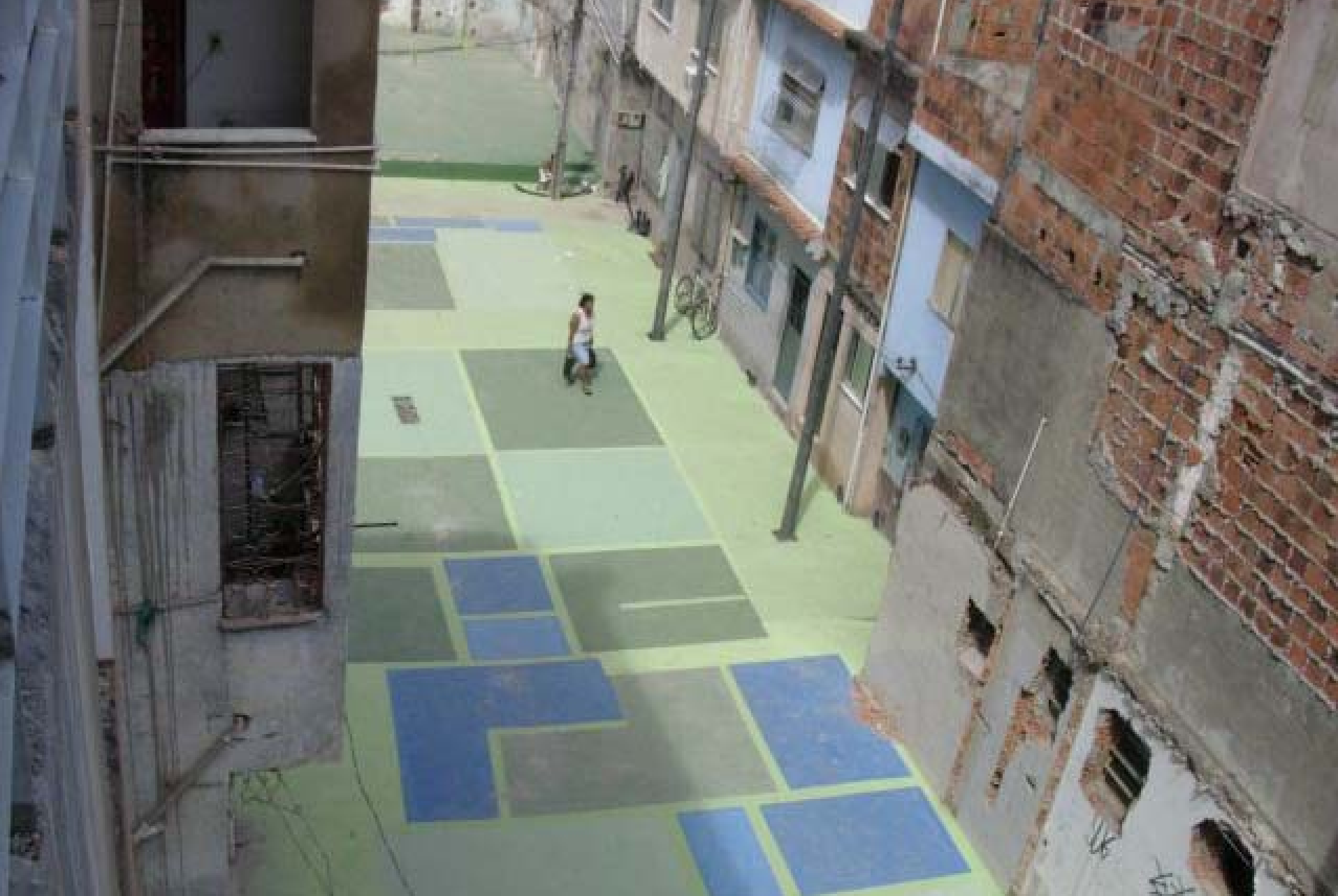
Teilrealisierung des Hofes – November 2003
